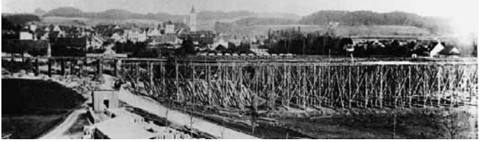
11 Schüttgerüste mit Loren 1889 rechts und links der Lindauer Straße in Wangen
