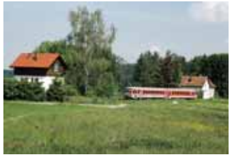
4 RB nach Hergatz am Bahnübergang Wallmusried, rechts ehemaliges Stationsgebäude, links Schrankenwärterhaus, privat genutzt
