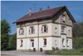
8 Bahnhofsgebäude Ratzenried, Erdgeschoss gemauert, erstes Geschoss geschindelt, Obergeschoss mit Brettern
